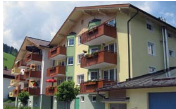
Abb.: Sanierung Reinbachsiedlung, St. Johann
