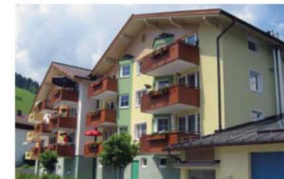
Abb.: Sanierung Reinbachsiedlung, St. Johann
